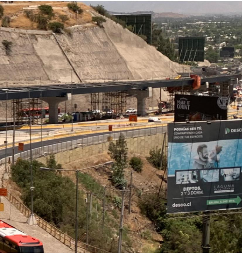
El Viaducto El Salto, que tendrá un largo de 1.202,25 metros, consta de tres tramos en su eje principal y 1 tramo en su ramal. La infraestructura está compuesta por 2 estribos, 2 pórticos y 24 cepas, de luces variables de entre 30 a 67 metros en su sección principal y 5 cepas y 1 estribo en su ramal.
