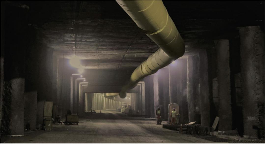
La trinchera convencional consiste en hacer una nivelación del terreno, aproximadamente a la cota donde se ejecutan las losas de superficie, desde ese nivel se realizan pilotes hasta la cota inferior de lo que será el túnel completo y solo entonces se puede excavar el nivel -1.
