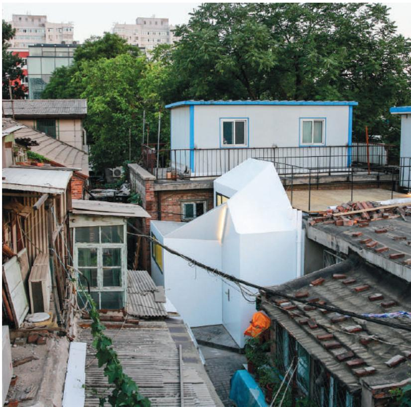
Mediante el desarrollo de un nuevo método constructivo basado en un sistema de paneles, en la *Courtyard Plugin House*, diseñada por *People's Architecture Office*, se construyen espacios temporarios dentro de los antiguos *hutong* de Pekín. En vez de reinventar la totalidad de la infraestructura, se refuncionalizan estructuras obsoletas al añadir piezas. Este sistema es modular, ligero y pensado como una solución temporal que vuelve habitables los edificios deteriorados de la capital china.
