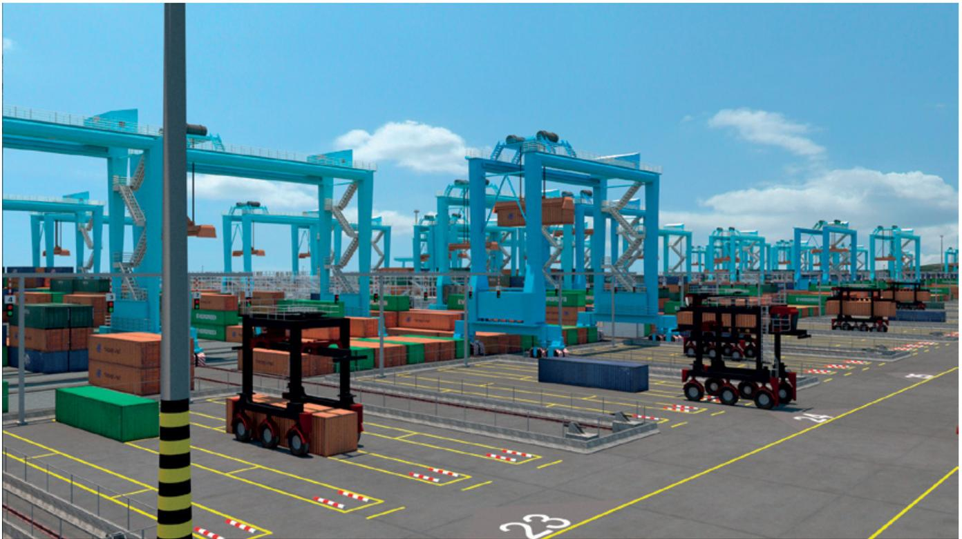
Cada terminal tendrá una longitud de muelle de 1.730 m, permitiendo el atraque simultáneo de cuatro grandes naves portacontenedores clase E (eslora 397 m, manga 56,4 m, calado 15,5 m y capacidad de 15.000 TEUs) y una superficie de acopio de más de 96 hectáreas, suficiente para operar anualmente hasta 3 MM TEUs cada una.
