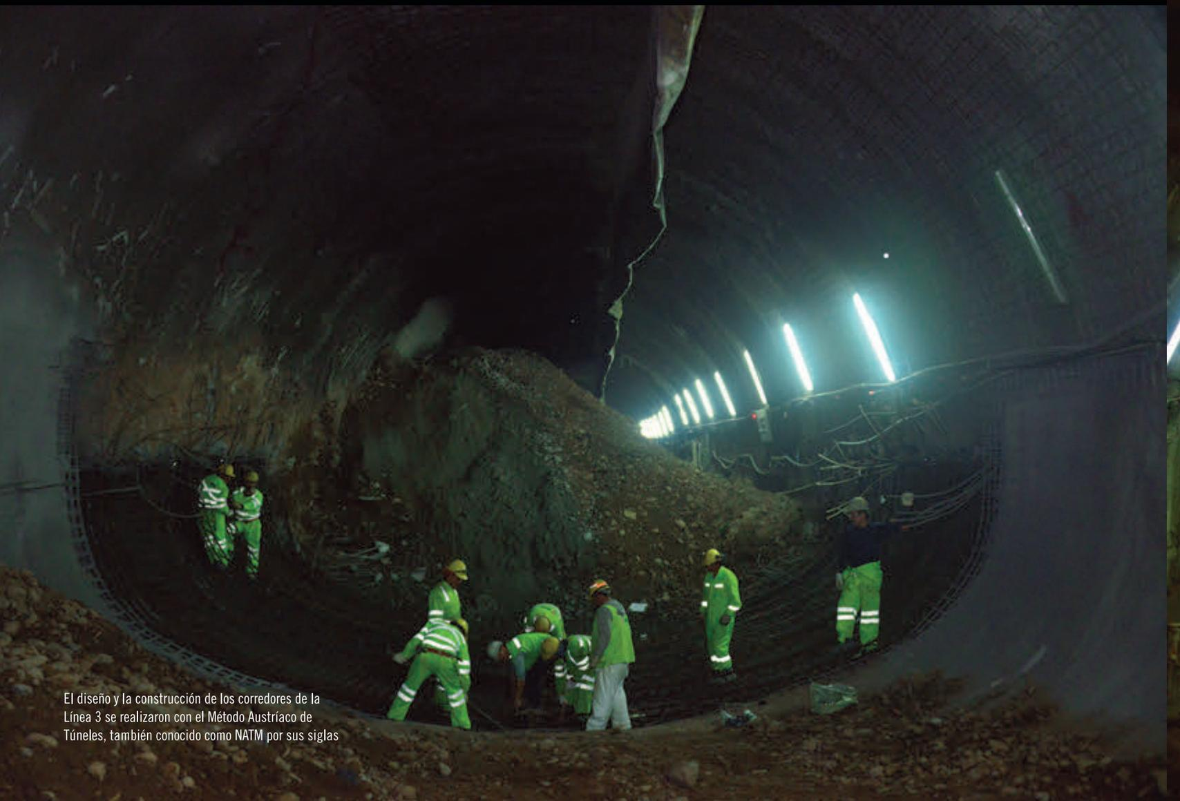
El diseño y la construcción de los corredores de la Línea 3 se realizaron con el Método Austríaco de Túneles, también conocido como NATM por sus siglas
