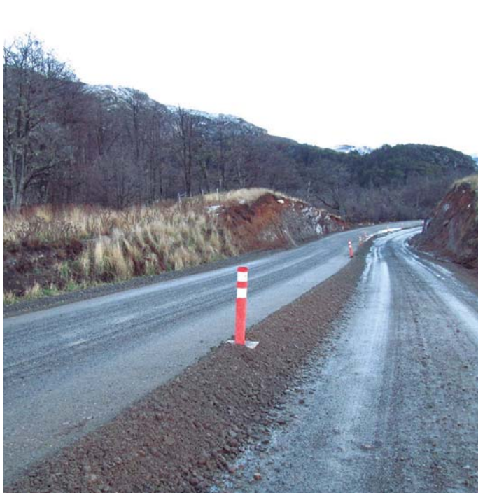
Trabajos en Cerro Castillo, sector Laguna Verde.
