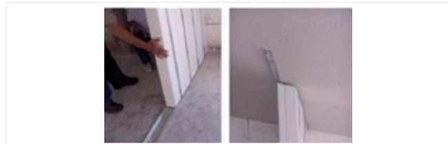
Del mismo modo se debe marcar en la losa de cielo la distribución de los muros de la misma forma como se realiza en los sistemas de paneles que se encuentran en el mercado. Se recomienda verificar la verticalidad de los muros antes de fijarlos definitivamente.
