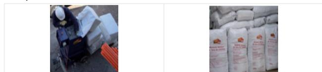
2. El contenido se vierte, en la obra, directamente en la tolva de una maquina móvil de instalación.
