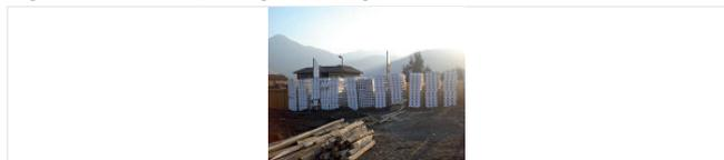
Los rayos ultravioletas del sol degradan al Poliestireno Expandido, sólo después de largas exposiciones a este. Si el almacenaje va a ser de larga duración es preferible proveer de sombra mediante algún techo o cubierta de lona, en los tiempos
