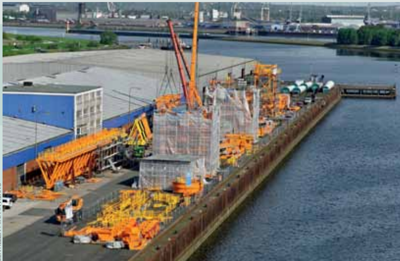
Los dos cargadores de barco, que se fabricaron por partes en las instalaciones de FAM Alemania, se trasladaban hasta el puerto de Bremen, donde se ensamblaron 8 piezas mayores por cada cargador.
