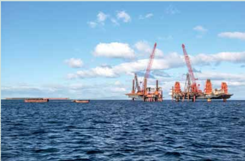
Montaje del Muelle con las dos plataformas Jack Up, una de ellas se trajo desde Puerto Montt a través del mar tirado por un remolcador y la otra desarmada en grandes piezas por vía terrestre.
