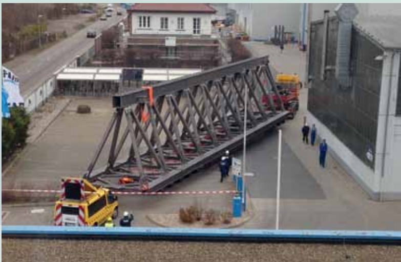
Fabricación de partes estructurales en la ciudad de Magdeburg en las instalaciones de FAM, Alemania.
