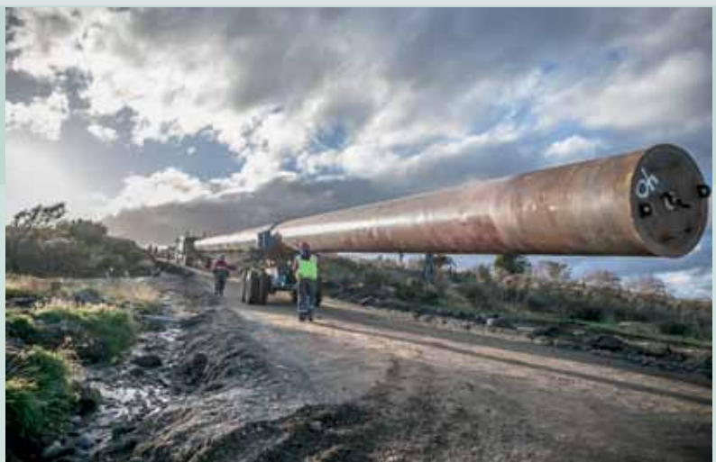
Traslado de pilotes desde cancha de empalme hasta el muelle de servicio.
