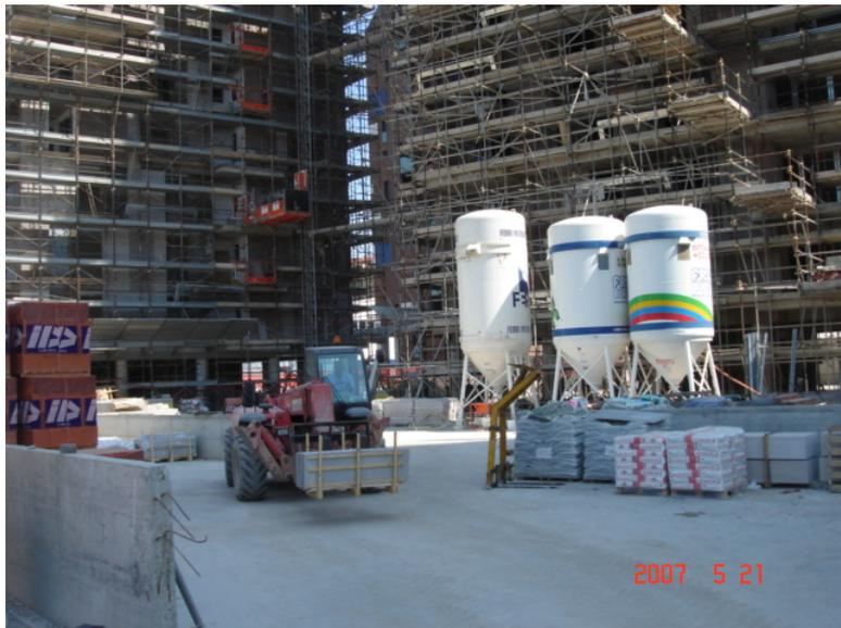
Obra de Constructora Marcora, mostrada por el Ing. Stefano, muestra andamios metalicos en todas las fachadas del edificio revestido en marmó que esta siendo transportado en patio de acopio;
