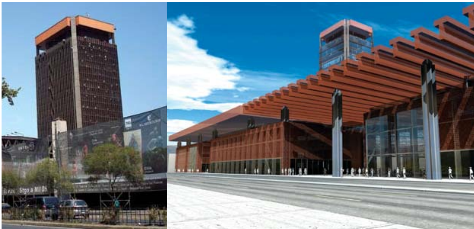
En marzo de 2006, tras el incendio, se suscitó un interesante debate respecto del destino que debía tener el edificio. ¿Las alternativas? Desde su reconstrucción hasta su total demolición. Finalmente, el Gobierno se decidió por recuperar el espíritu original de la obra, vale decir, reconvertirla en un centro cultural abierto a la ciudadanía.
