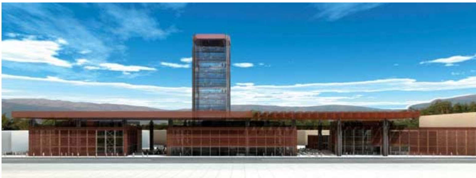
Este nuevo centro cultural será uno de los principales hitos arquitectónicos y constructivos de la capital con miras al Bicentenario. Por lo mismo, y como reconoce Cristián Fernández, “es un edificio que tiene que encarnar la imagen de un Chile proyectado hacia el futuro”.
