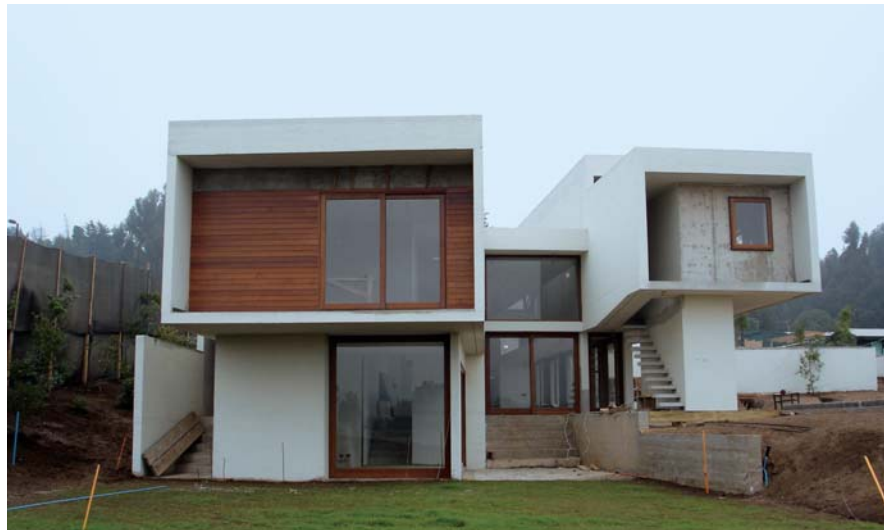
CASA DE LAS ESTANCIAS PRESENTES, JOSÉ CRUZ. Ubicada en un plano inclinado, posee 2 niveles para alcanzar la calle.
