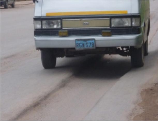
Pavimento asfáltico con fallas de calidad graves, observe los desniveles.
