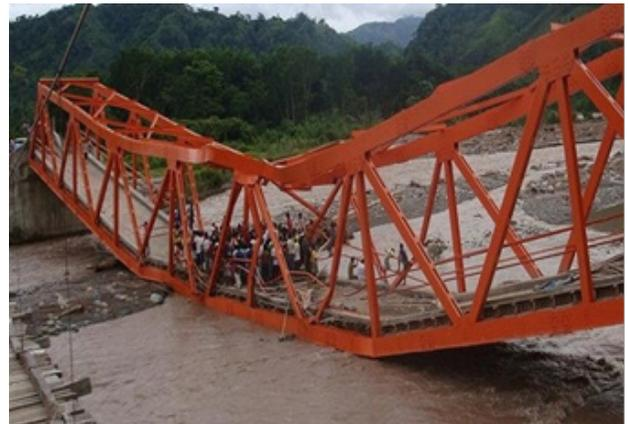
Colapso de un puente dentro del propio proceso constructivo.
