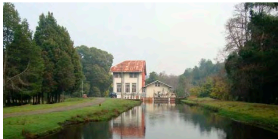
Central Hidroeléctrica Llollehue
