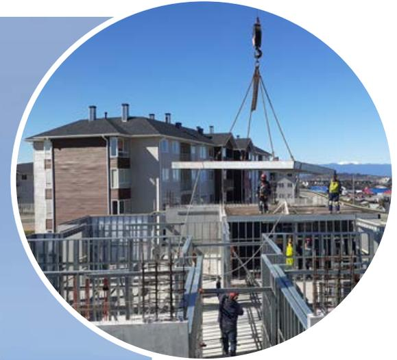
En Altavista, se utilizó moldaje de aluminio manuable junto con hormigón autocompactante, lo que permitió lograr muros con buena terminación y variabilidad milimétrica, permitiendo sacar el uso de yesos en los muros. Adicionalmente, se utilizaron: muros de metacón prefabricados, paneles de losa de metacón, cerchas prefabricadas y paneles de cubierta.
