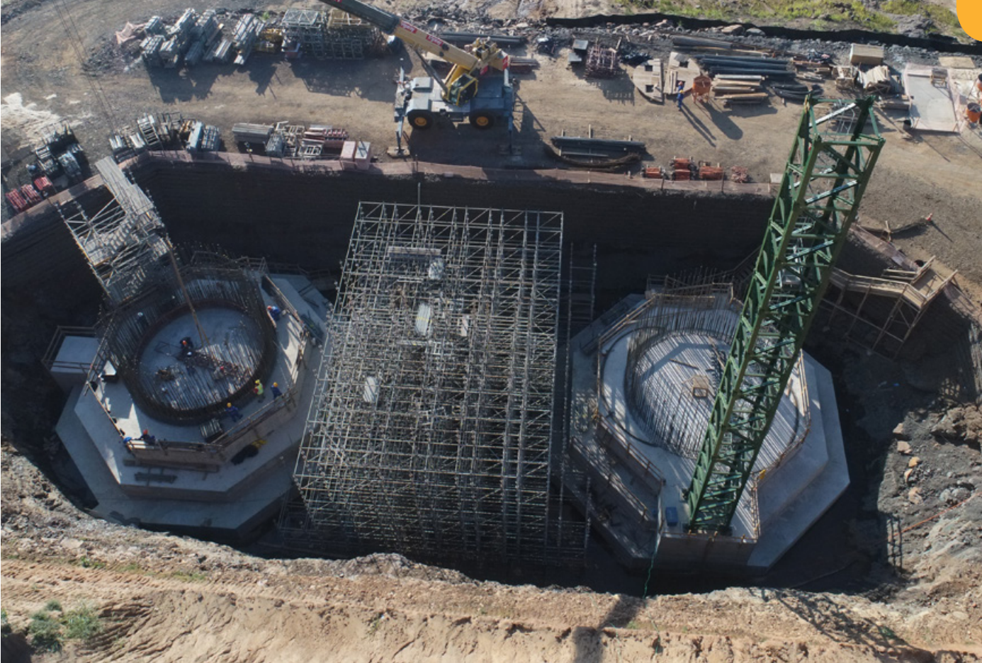
Ejecución de los pilares del mástil en el lado paraguayo.
