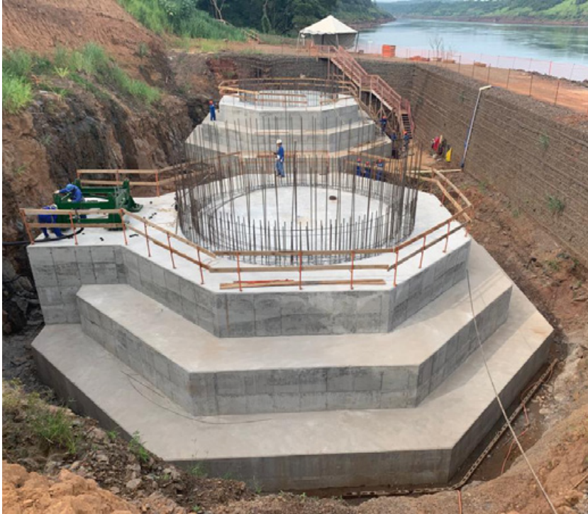
Preparación para el inicio de la ejecución de los pilares del mástil principal en el lado brasileño.
