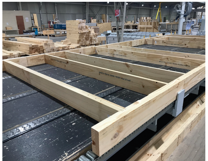
La empresa ha sido pionera en incorporar los prefabricados en la construcción de viviendas.
