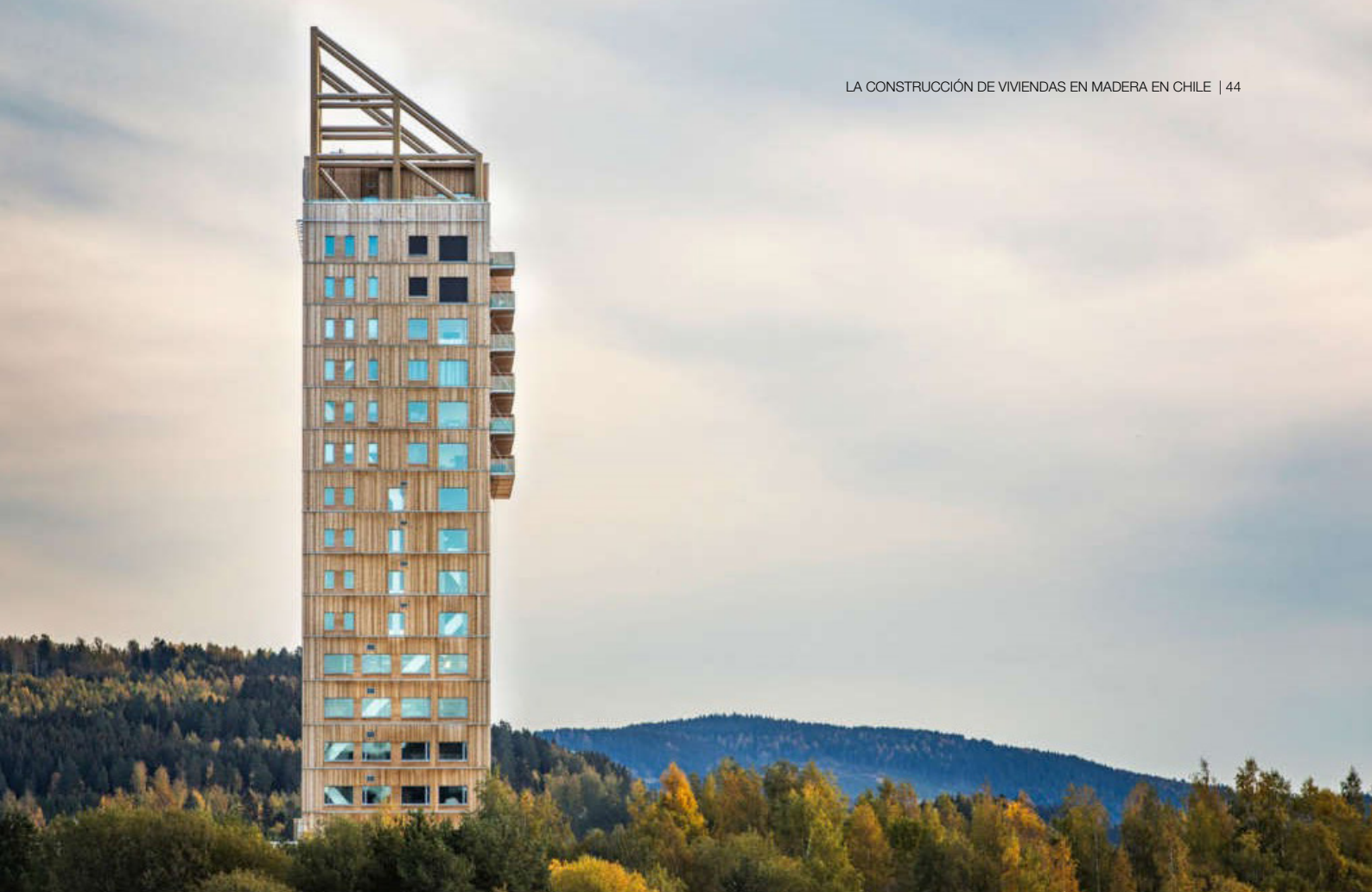
Figura 33: Edificio Mjøstårnet de 18 pisos de altura en madera, alberga viviendas y oficinas, entre otros programas de uso. Fuente: https://www.avontuura.com/mjostarnet-by-voll-arkitekter/ .
