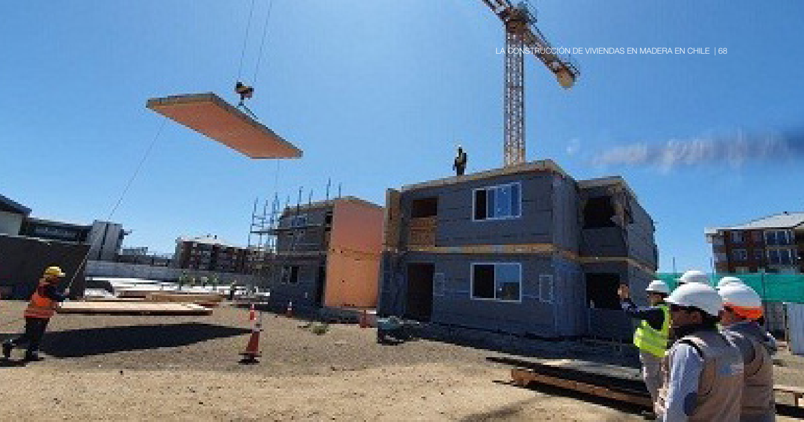
Figura 39: Construcción edificio Horizonte del Pacífico por empresa E2E Chile Fuente: www.tribunadelbiobio.cl
