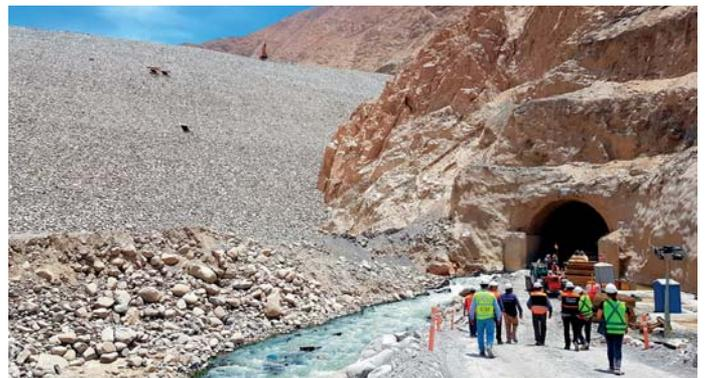
una extensión de 473 metros y una capacidad para evacuar hasta 381 metros cúbicos por segundo. Esto permitió dejar el espacio necesario para la construcción de la presa, el punto más central de este embalse, que puede almacenar 17 millones de metros cúbicos. El tranque tendrá un muro de 76 metros de altura por 274 metros de largo y ocu-
