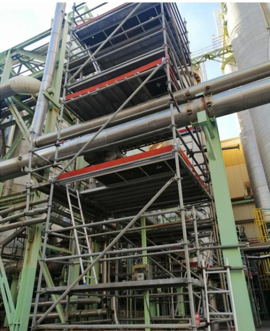
**FLEXIBILIDAD:** El Andamio Multidireccional tiene una gran flexibilidad en su uso. Los puntos de conexión permiten múltiples posiciones de los elementos para realizar diseños funcionales que se adaptan a diversas geometrías.
