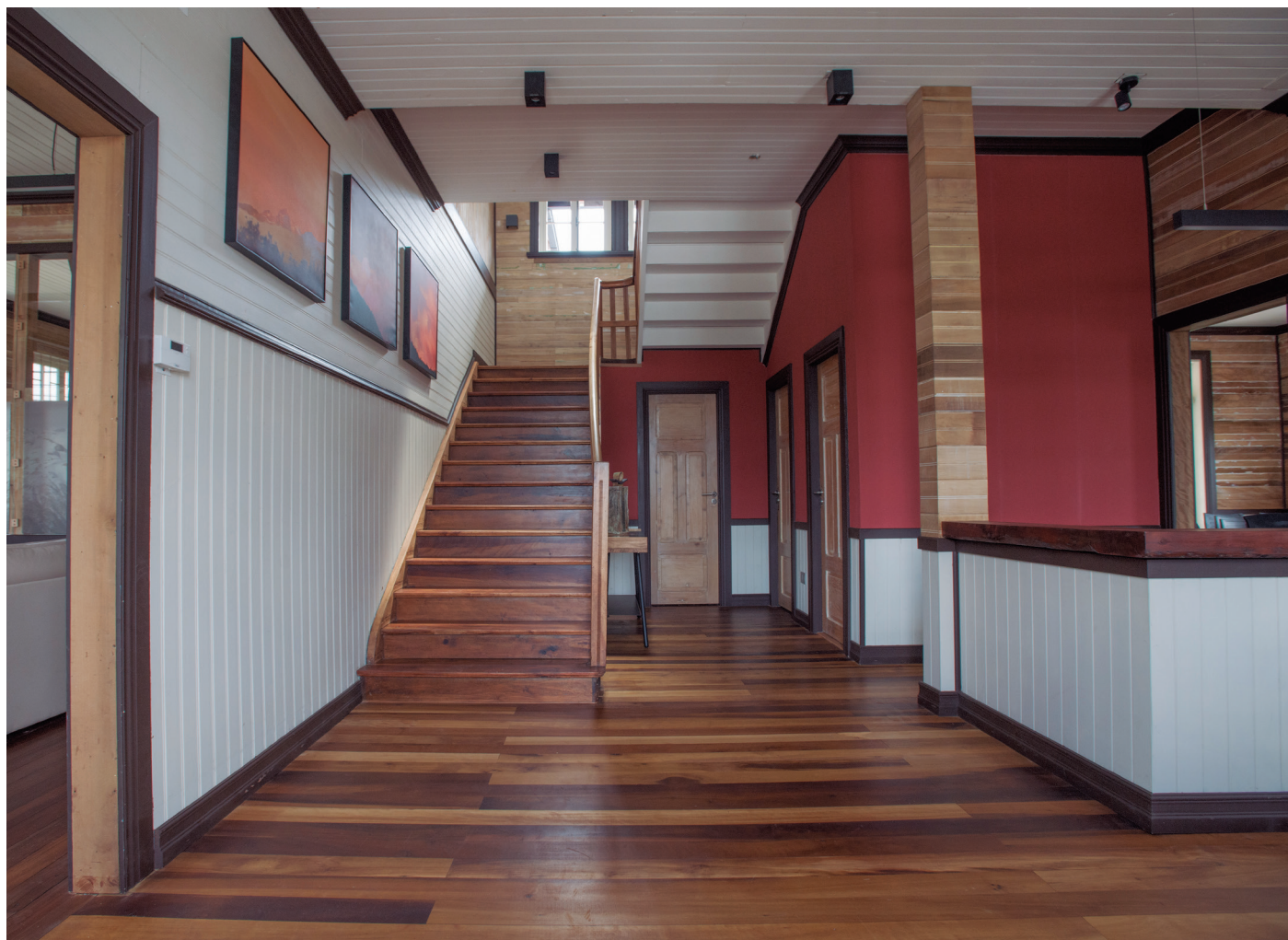
Se rescataron las maderas de la estructura, muros y pisos, las cuales fueron raspadas y acondicionadas para poner en valor este material.
