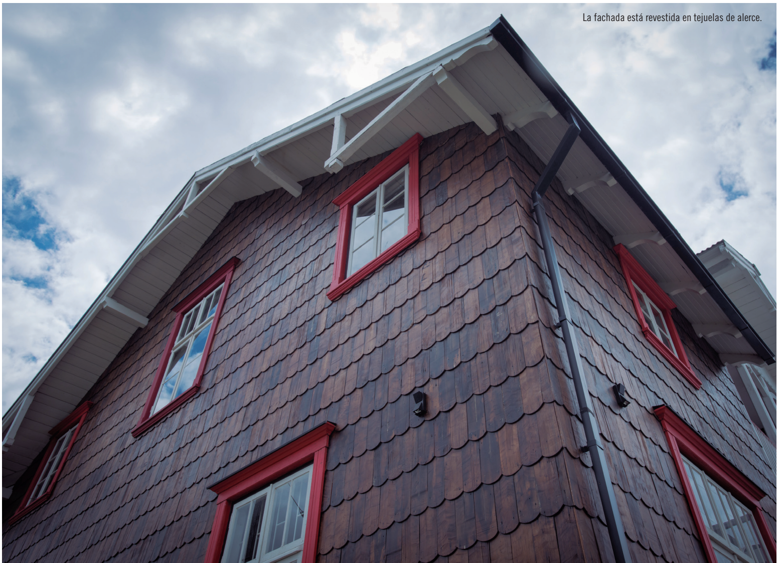
La casa fue construida entre 1925 y 1930 con pilares y vigas de madera ensambladas.
