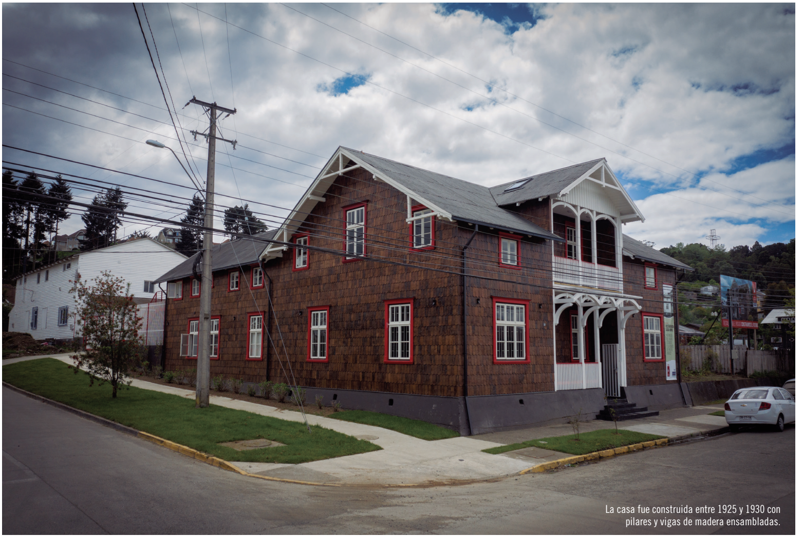
La fachada está revestida en tejas de alerce.
