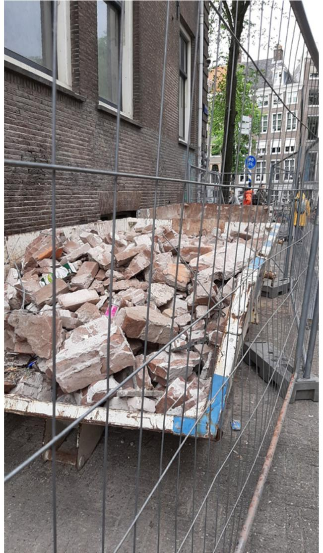
Figura 57: Contenedores para recogida selectiva, maderas y escombros, Amsterdam 2019. Gentileza A. Tapia
