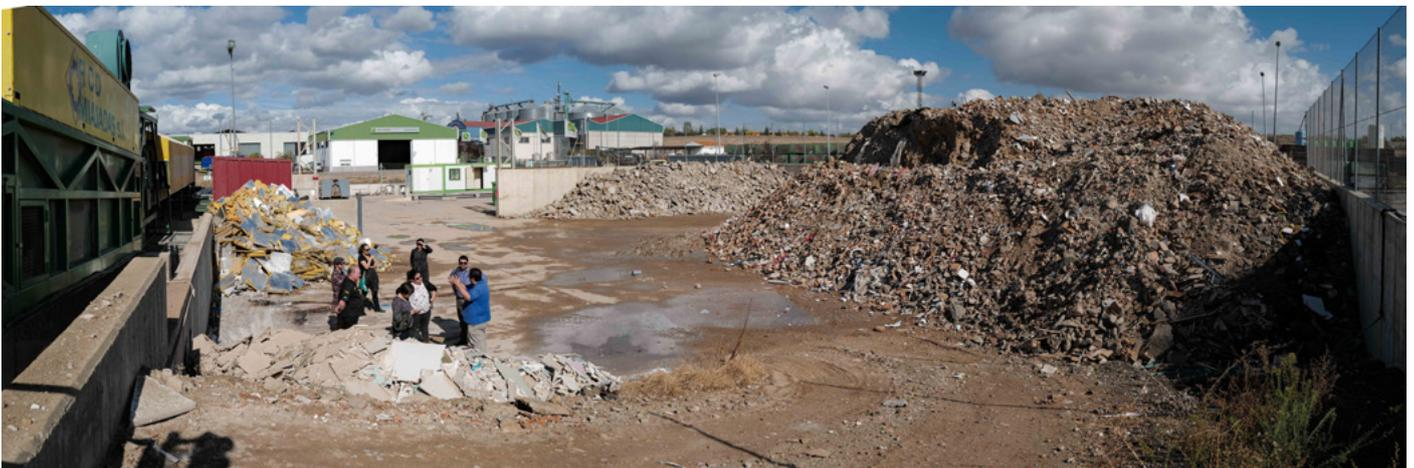
Figura 33: Patio de copio de residuos segregados, provenientes de obra de demolición. Centro gestor de residuos de la construcción y demolición “RCD Miajadas”. Gentileza de José Pedro Campos, Instituto de la Construcción.
