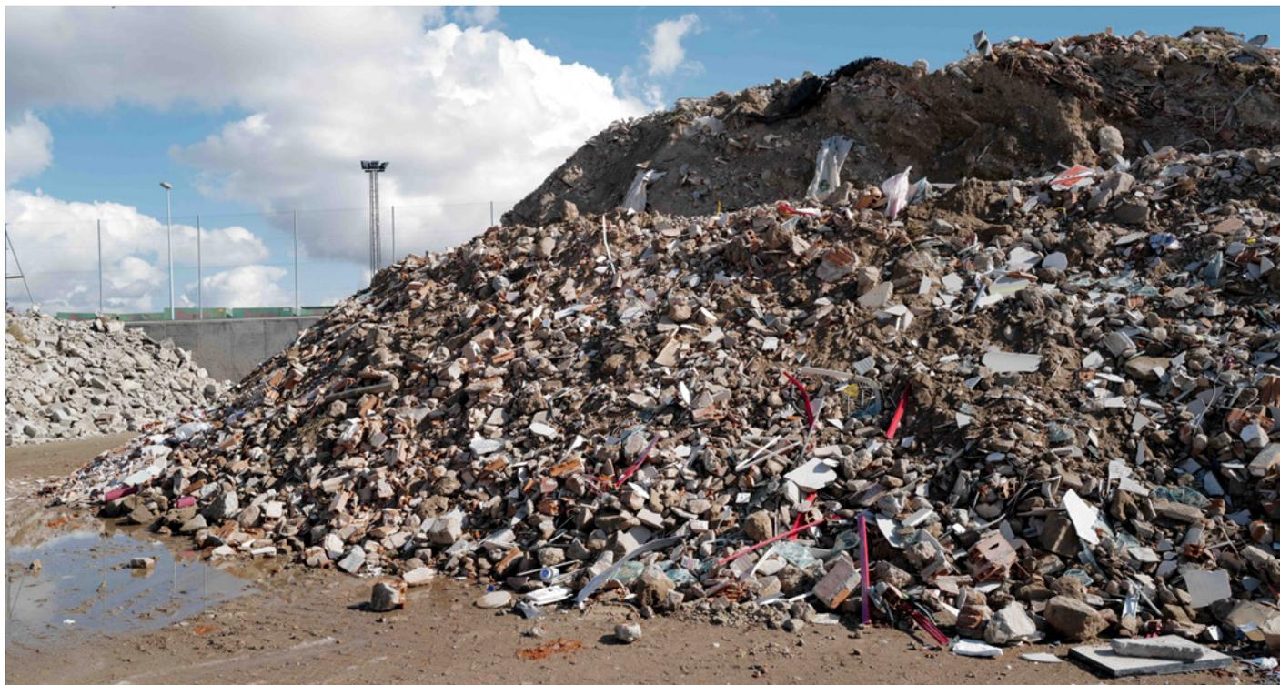
Figura 35: Residuos provenientes de obra de demolición. Centro gestor de residuos de la construcción y demolición "RCD Miajadas". Gentileza de José Pedro Campos, Instituto de la Construcción.
