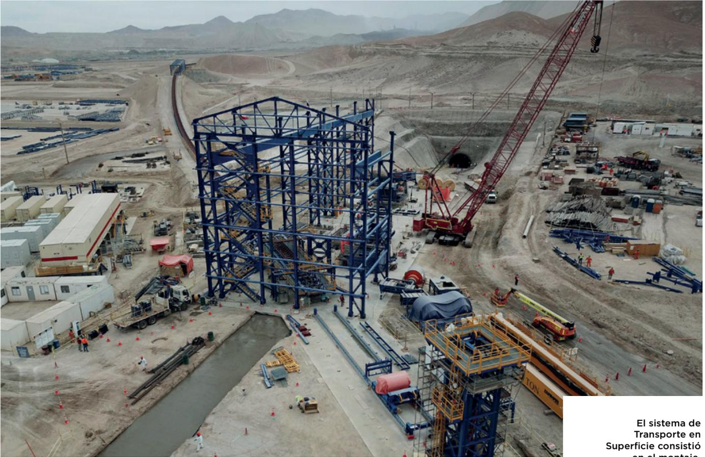
El sistema de Transporte en Superficie consistió en el montaje, instalación y puesta en marcha de dos correas transportadoras y un silo de distribución que incluye dos correas alimentadoras.
