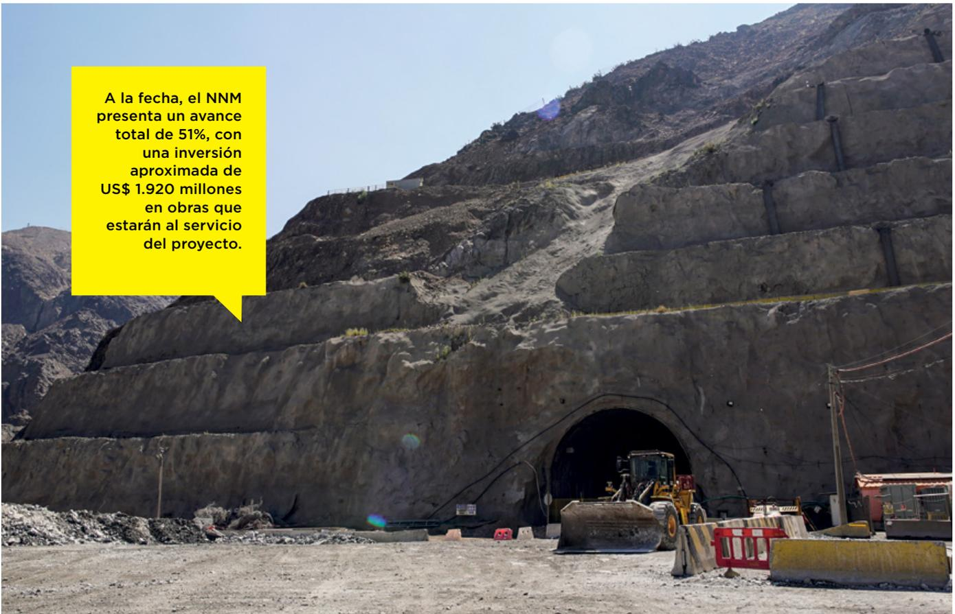
Se suma el avance de 15 km de un total de 20 km de túneles de acceso, tanto para personal como de transporte de mineral.
