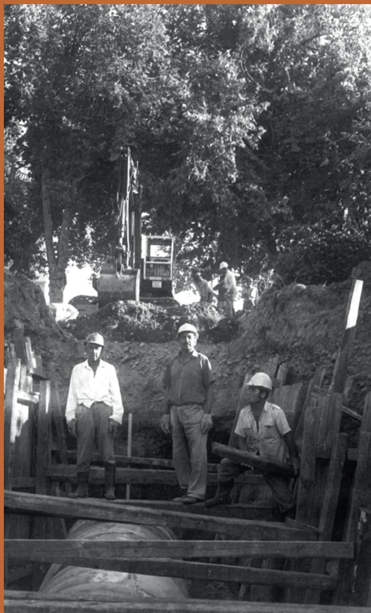
▲ **Trabajadores estribando tubos para evitar el derrumbe.**
