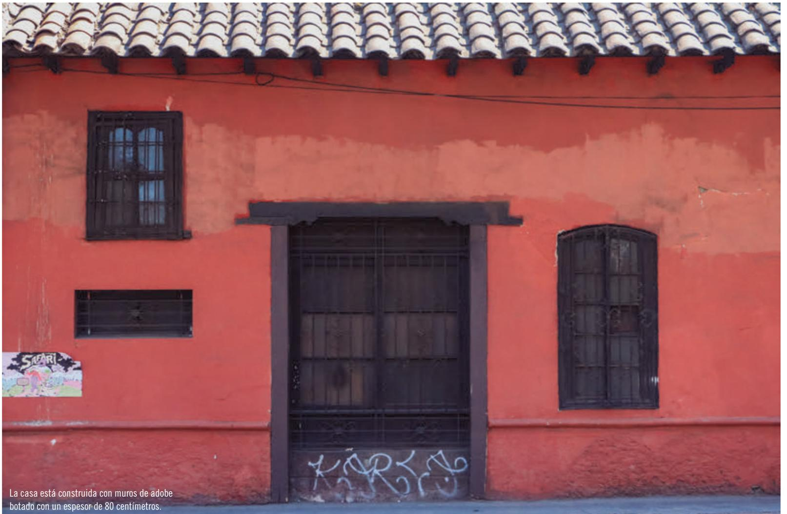
La casa está construida con muros de adobe botado con un espesor de 80 centímetros.
