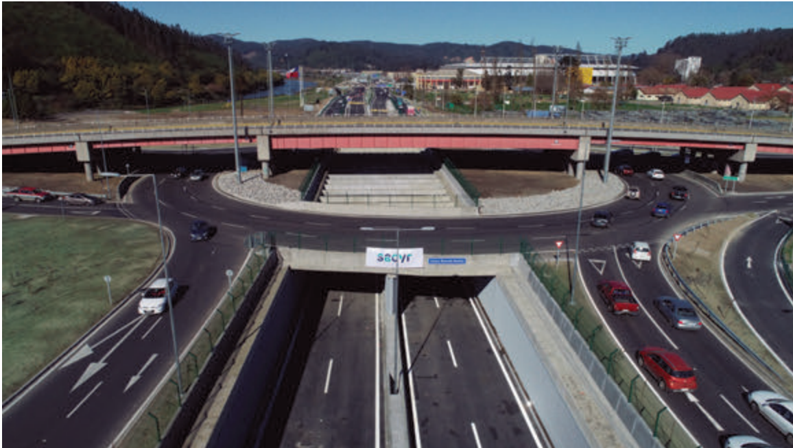
La rotonda es parte de las 37 obras complementarias propuestas para ser incorporadas al contrato de concesión de la autopista Concepción-Cabrero.
