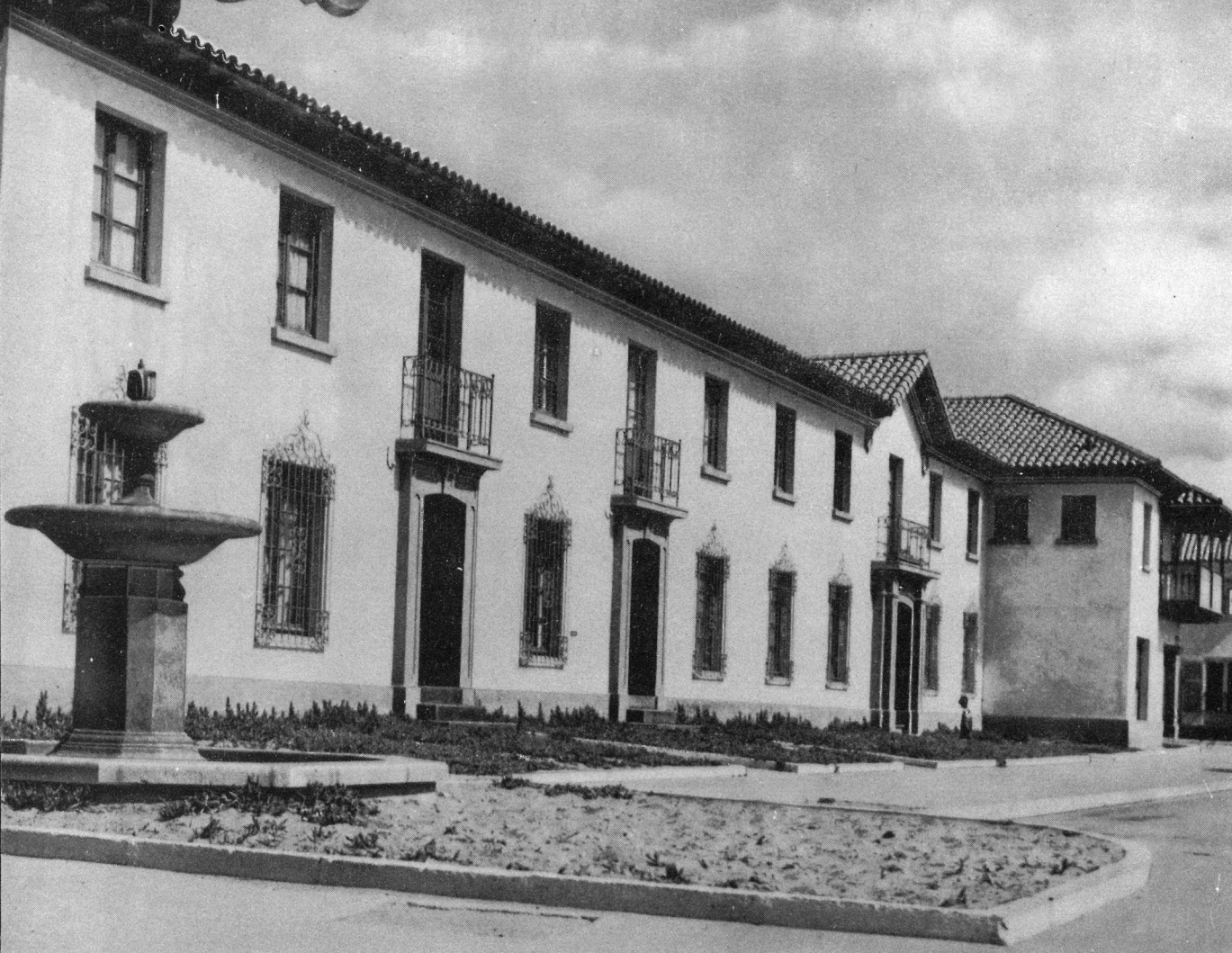
CONSTRUCCIONES DE VIVIENDAS DE DEPARTAMENTOS EN LA AVENIDA PEDRO PABLO MUÑOZ.
