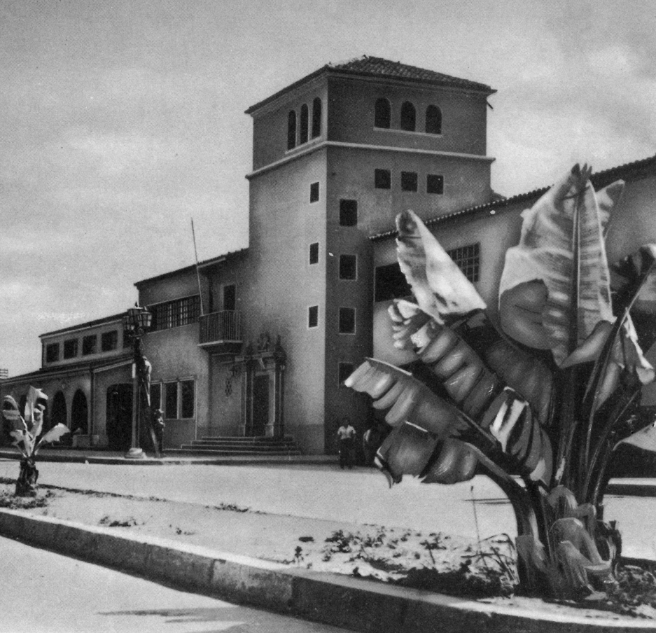
FACHADA DE LA ESTACIÓN DEL FERROCARRIL.
