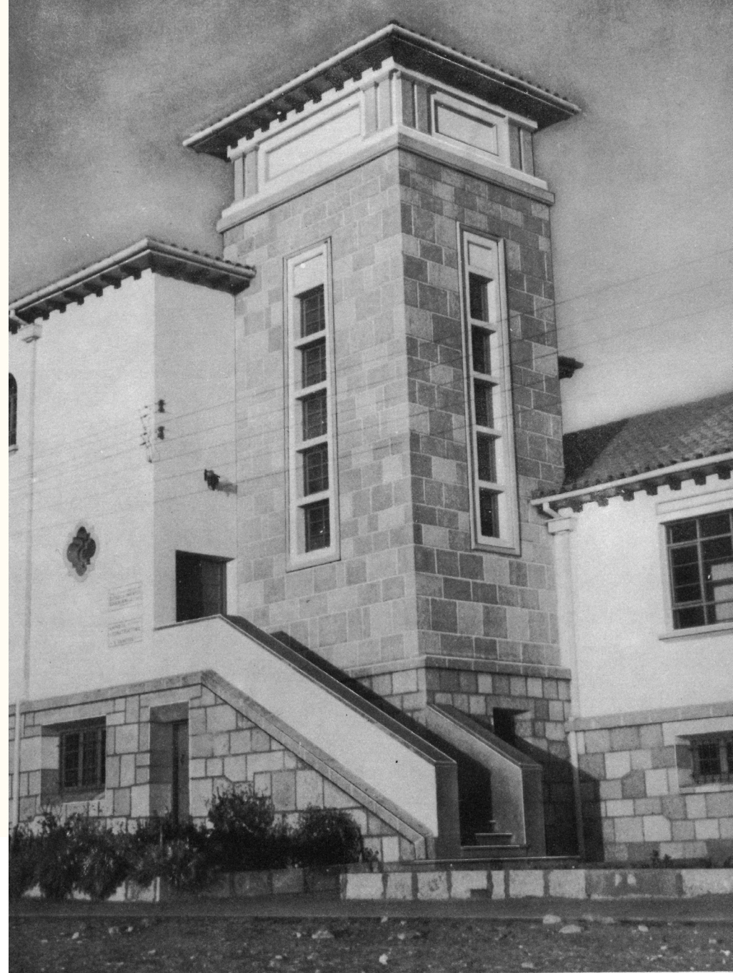
FACHADA DEL EDIFICIO DE LA INSPECCIÓN ESCOLAR.
