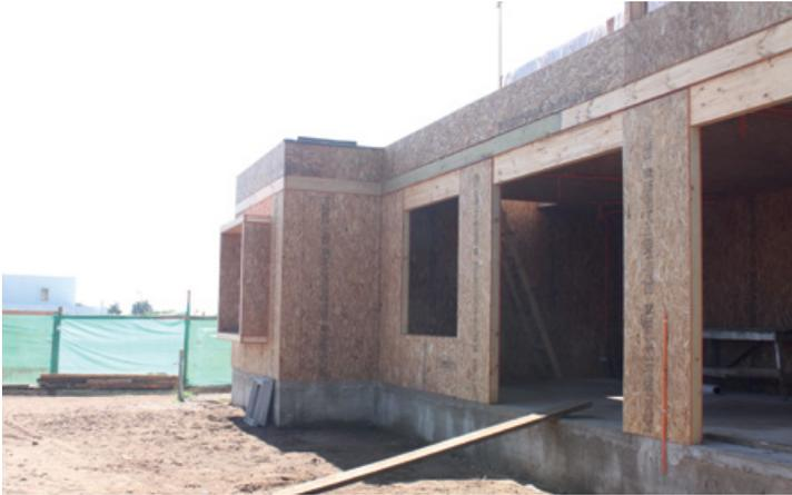
**Otra alternativa de solución prefabricada son los paneles SIP, sistema de construcción fabricado de manera automática bajo condiciones controladas.**
