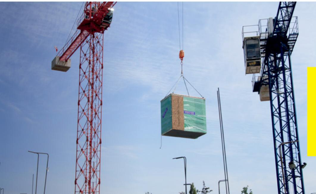
**En la construcción modular, los productos se construyen en la misma fábrica y salen de ahí prácticamente listos. En el caso de Tecno Fast, por ejemplo, pueden optimizar entre un 50% y 65% los plazos de entrega con sistemas que destacan la flexibilidad, los costos, la calidad, la resistencia y la sustentabilidad.**
