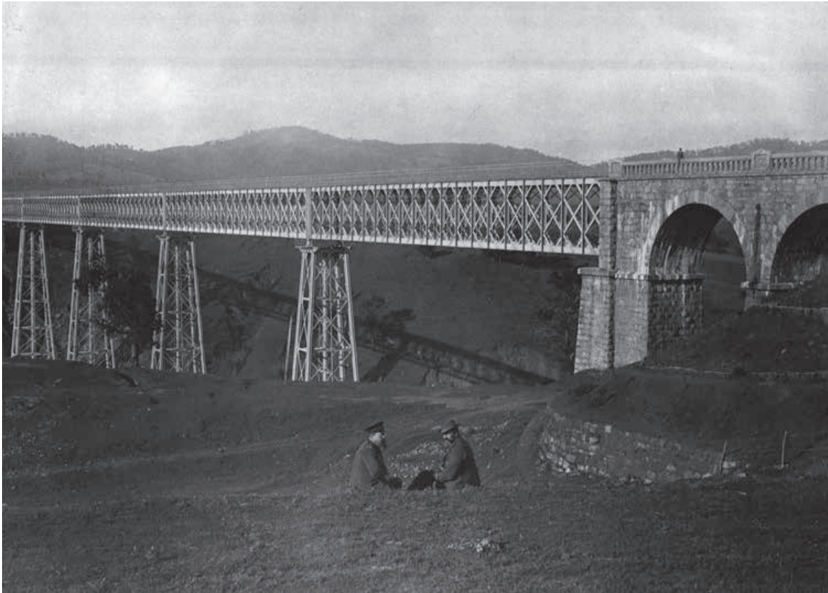
⚙ Viaducto del Malleco, Araucanía, 1930 Negativo gelatinobromuro de plata sobre vidrio Colección Museo Histórico Nacional
