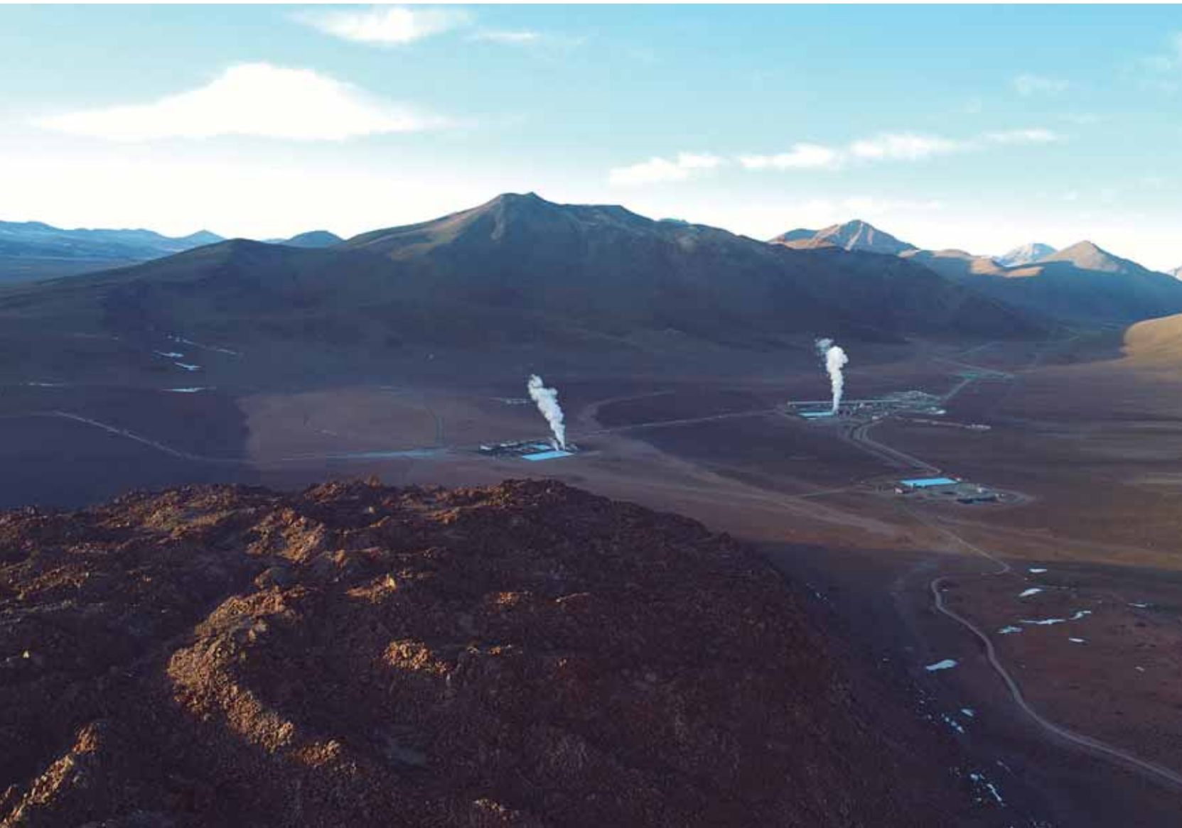
La central cuenta con diez pozos, seis de los cuales están destinados a la producción y cuatro para reinyectar el fluido térmico.
