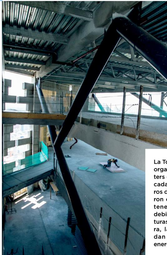
La Torre Reforma se organiza en 14 clústers de cuatro pisos cada uno. Los muros de concreto fueron diseñados para tener movimiento debido a sus aberturas de triple altura, las cuales ayudan a disipar la energía sísmica.
