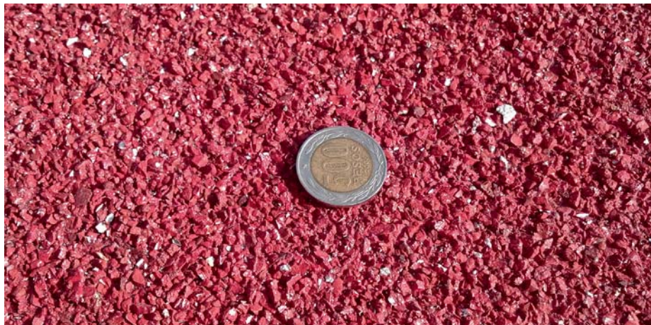
Sello asfáltico para alta fricción (foto gentileza de Bitumix).
