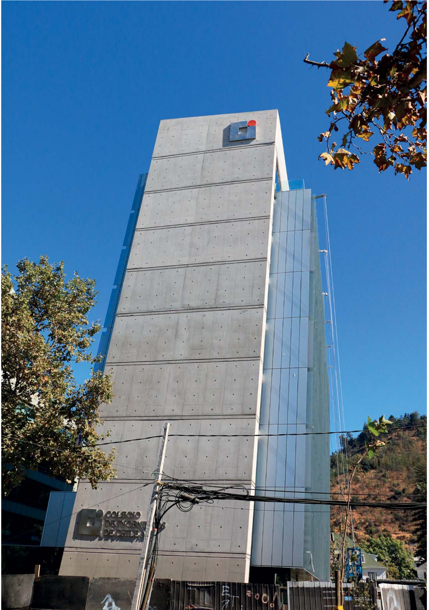
El edificio tiene dos fachadas con hormigón, que dan hacia avenida Santa María y la calle Fernando Manterola, y otras dos con muro cortina.
