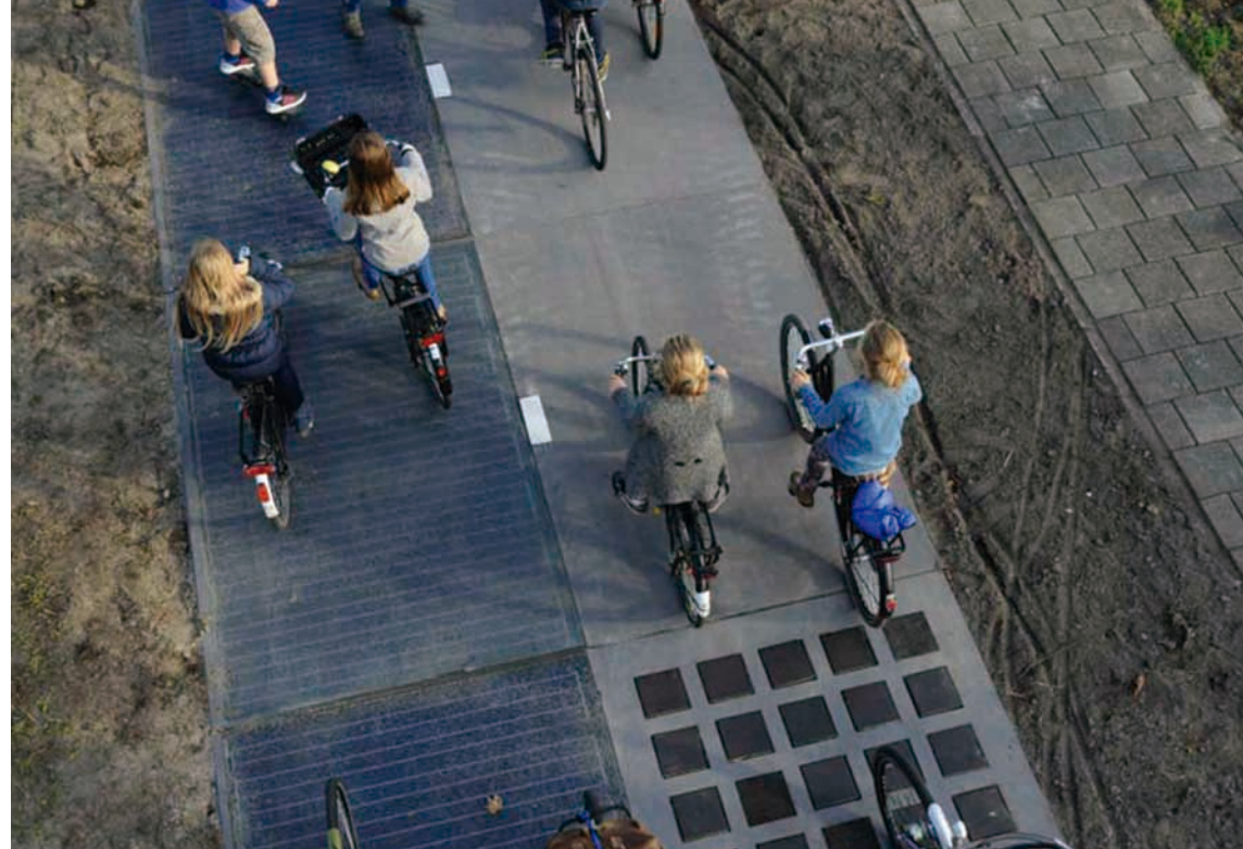
CICLOVÍA SOLAR, ÁMSTERDAM
