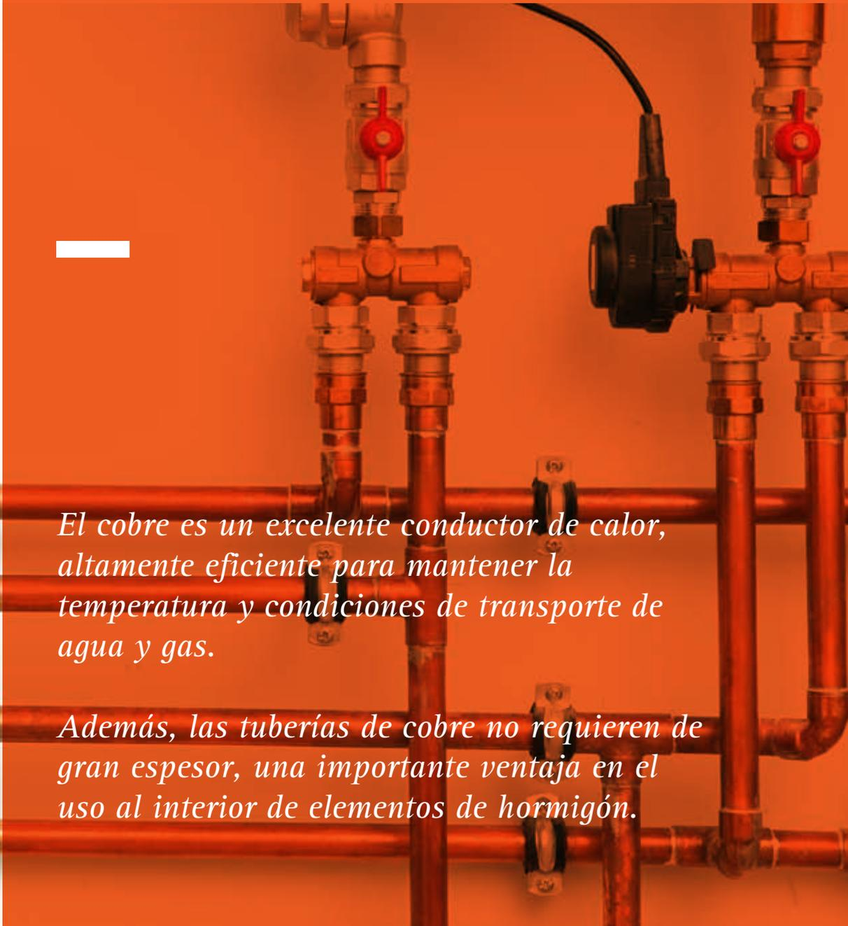
*El cobre es un excelente conductor de calor, altamente eficiente para mantener la temperatura y condiciones de transporte de agua y gas.*
