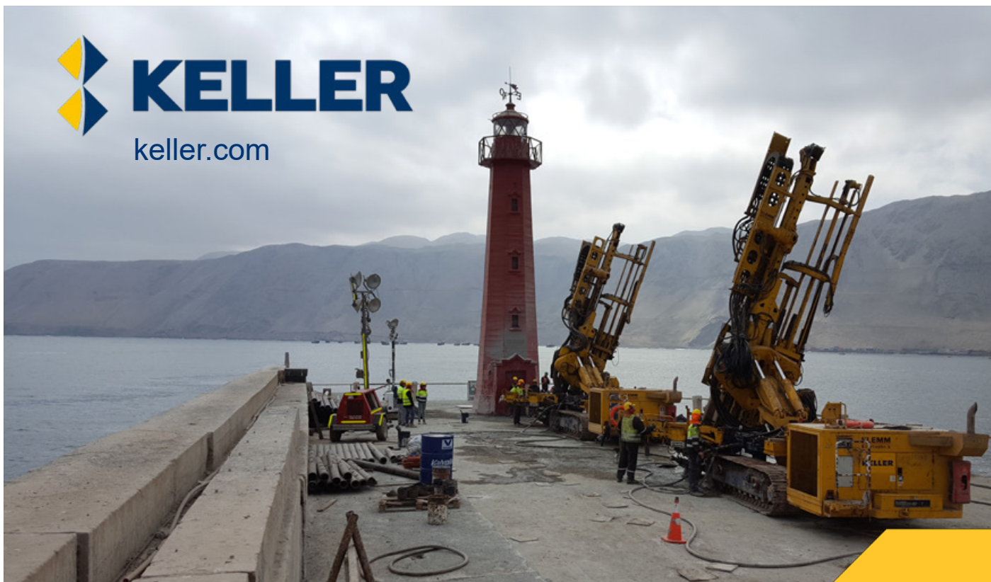
Micropilotes en Reparaciones Portuarias (CHILE)
