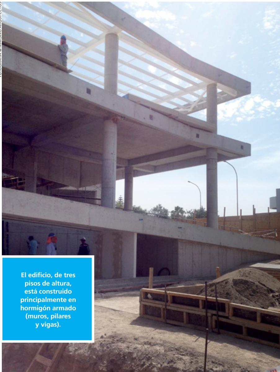
El edificio, de tres pisos de altura, está construido principalmente en hormigón armado (muros, pilares y vigas).
