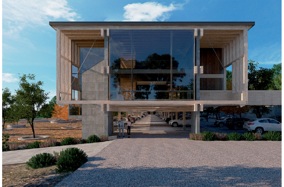
El volumen del edificio descansará en pilares de madera de 30 por 30 centímetros, apoyados sobre pedestales de hormigón de 70 centímetros de alto.
