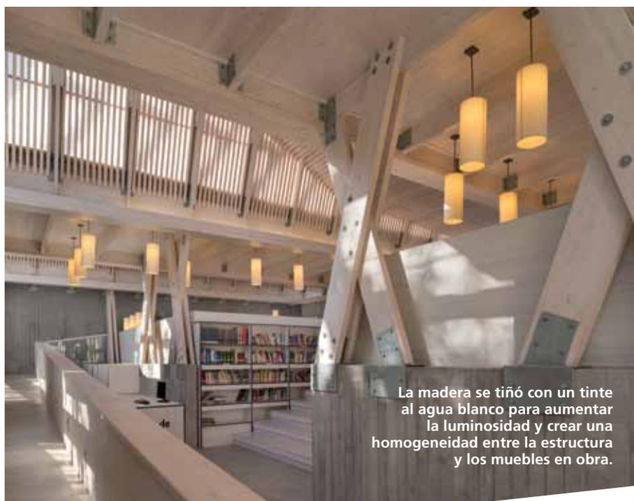
**La madera se tiñó con un tinte al agua blanco para aumentar la luminosidad y crear una homogeneidad entre la estructura y los muebles en obra.**
