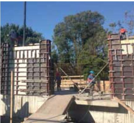
Se elevó el piso principal de la zona de lectura a un metro sesenta sobre el nivel de la calle. Los muros de hormigón visto sostienen la estructura de madera.
