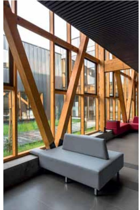
Las piezas de madera fueron cortadas en un proceso llamado mecanizado, donde cada una de las piezas estructurales se montaron y se confeccionaron para su instalación en obra.
