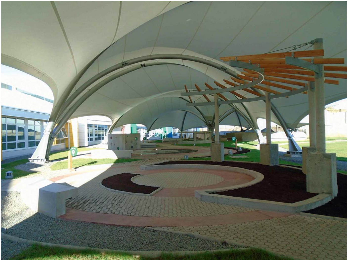
La obra incluye un patio cubierto por un techo de PVC tensado en un sector exterior.
