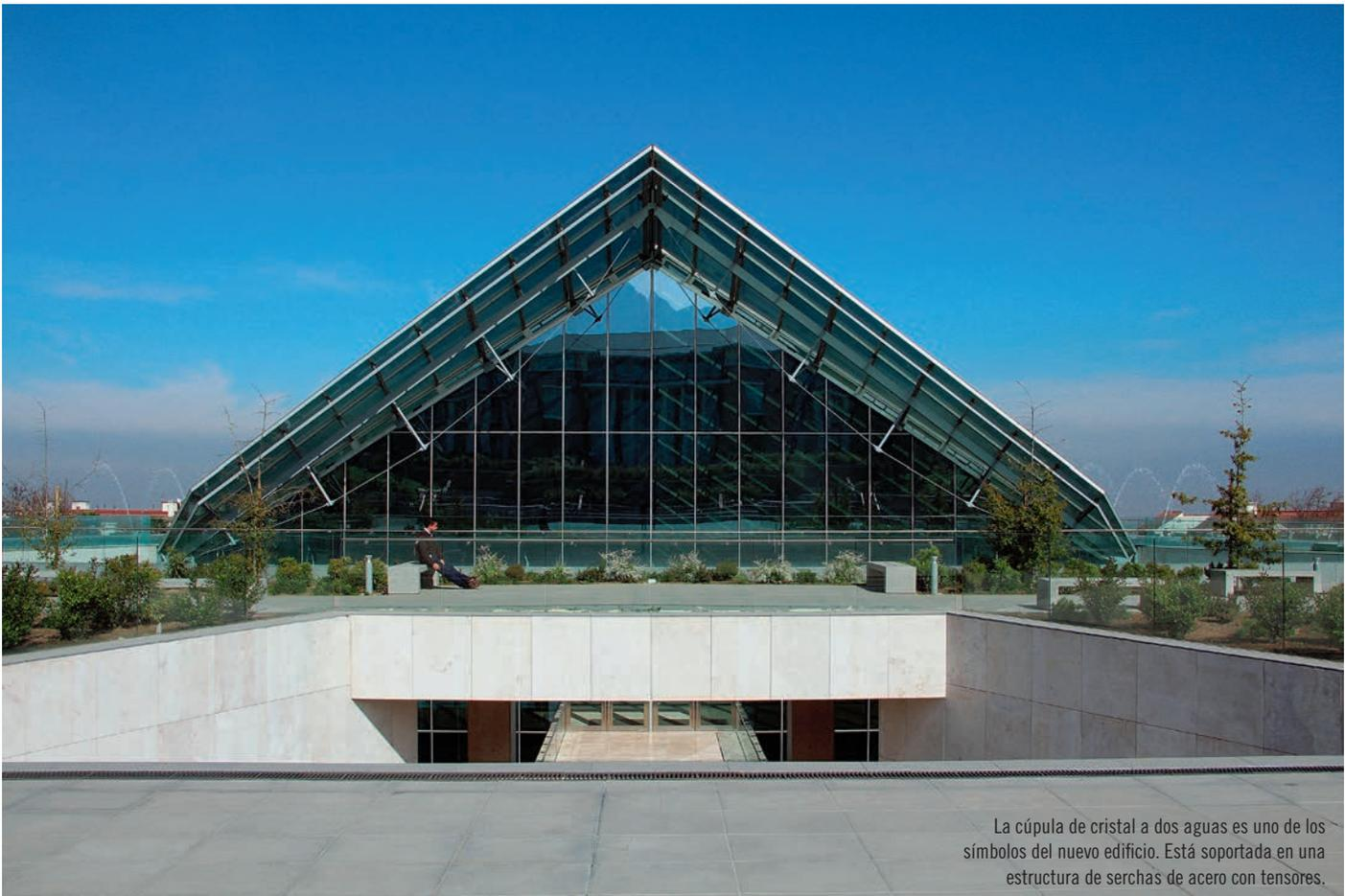
La cúpula de cristal a dos aguas es uno de los símbolos del nuevo edificio. Está soportada en una estructura de serchas de acero con tensores.
