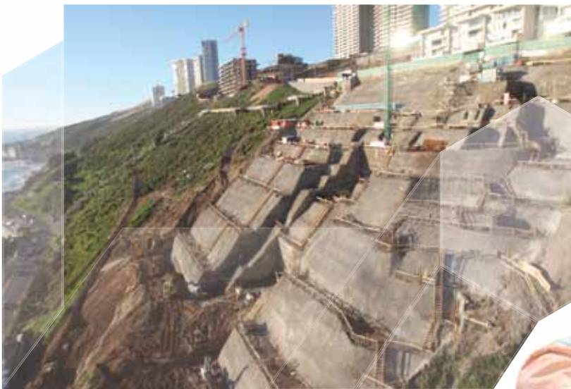
ENTIBACIÓN DE TALUDES Y FUNDACIONES. TERRAZAS DE COCHOA, REÑECA.
