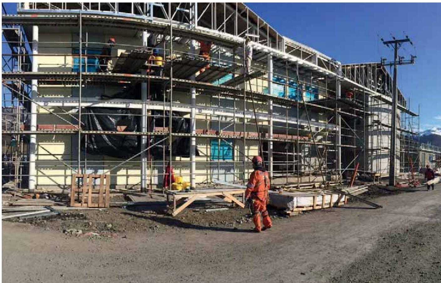
El recinto está construido con una estructura metálica de acero y losa colaborante de hormigón armado, que constituye el segundo nivel.
