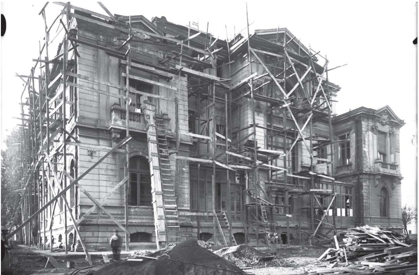
Construcción del Instituto de Higiene.
