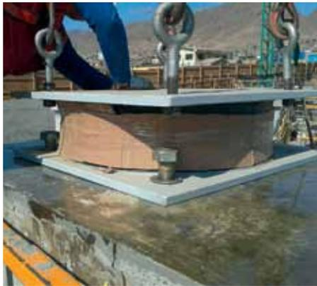
**El hospital contará con aislación sísmica, gracias al uso de 280 aisladores sísmicos y 139 deslizadores friccionales.**
