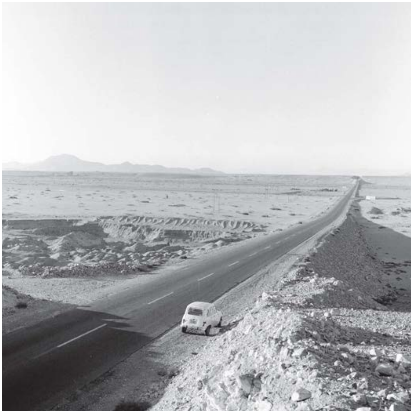
Construcción Carretera Panamericana Norte, Copiapó a Taltal, 1975. INGECIL.
