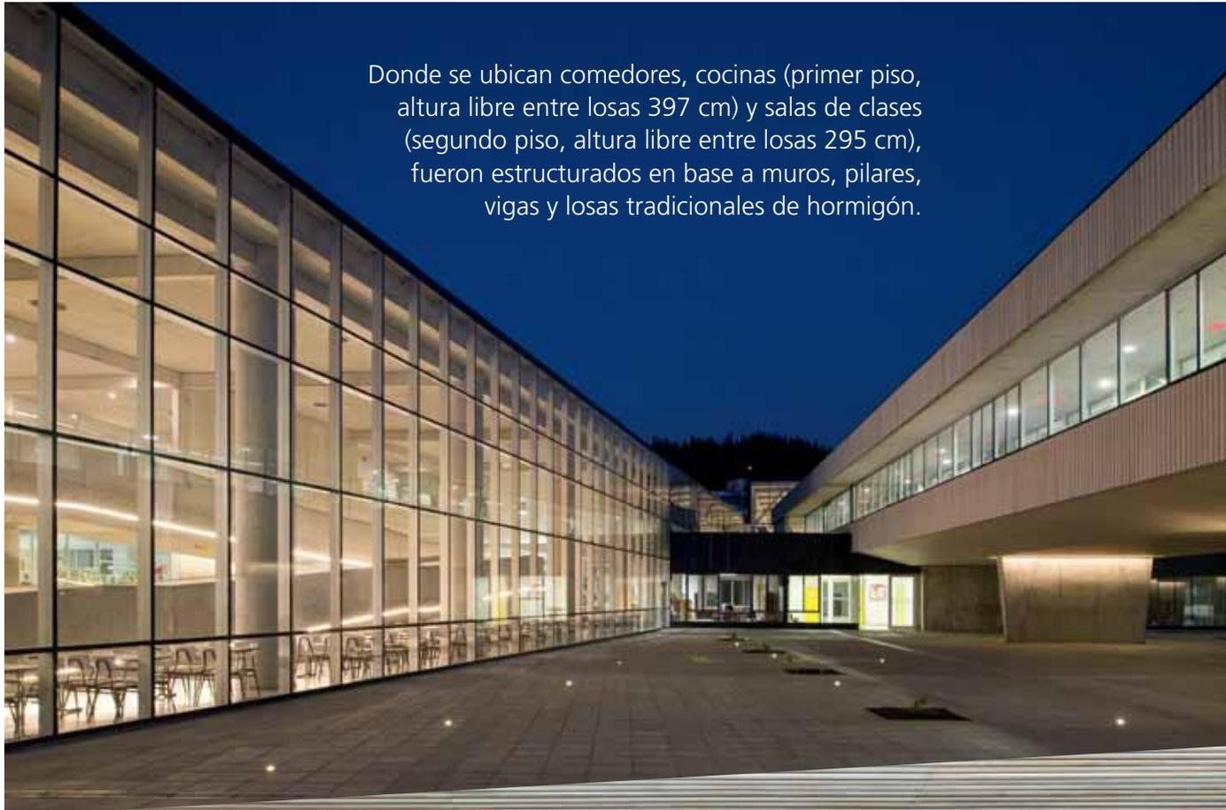
Donde se ubican comedores, cocinas (primer piso, altura libre entre losas 397 cm) y salas de clases (segundo piso, altura libre entre losas 295 cm), fueron estructurados en base a muros, pilares, vigas y losas tradicionales de hormigón.
