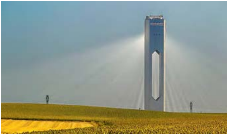
La planta de CSP permite guardar energía solar. En el caso de Atacama 1, ésta podría utilizarse hasta 17,5 horas después.
