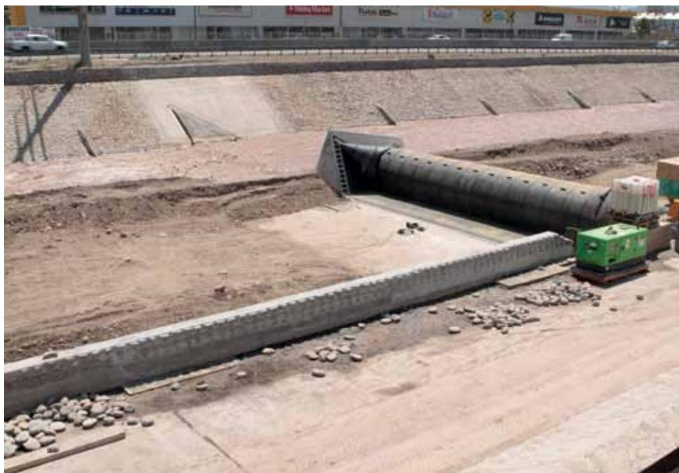
Para generar los espejos de agua se proyectaron tres pares de barreras inflables con aire en el lecho del río. Estas están hechas de goma 100% caucho EPDM con 2 capas de tela de refuerzo de poliéster, de 13 mm de espesor (el cuerpo) y 7 mm de recubrimiento exterior, que se ancla al hormigón por medio de placas y pernos.
