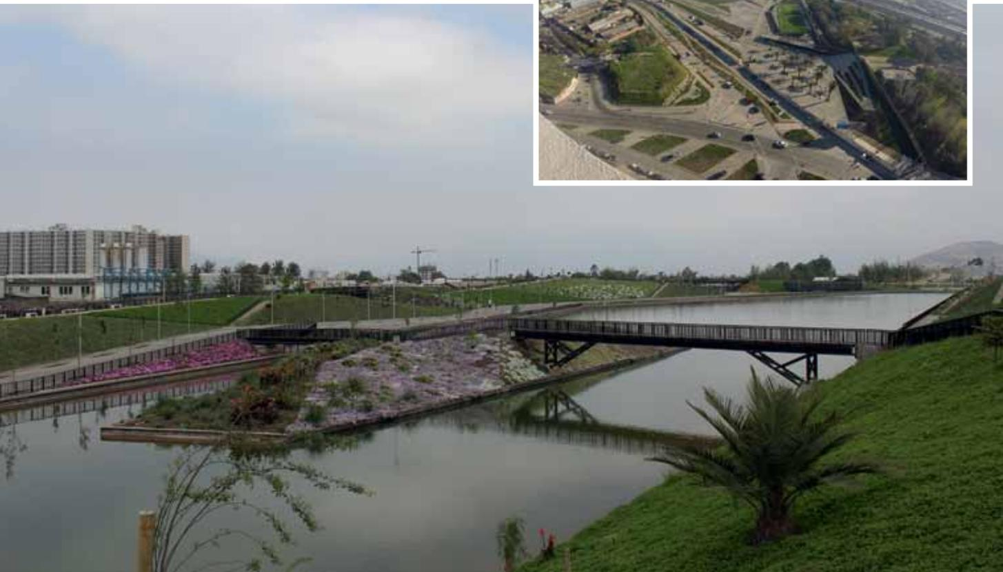
Entrecruzando el parque hay ocho pasarelas peatonales que corresponden a estructuras metálicas empotradas mediante el sistema de pilotes y pilas en fundaciones de hormigón, que conectan tanto la parte "continental" como las dos islas que lo componen.
