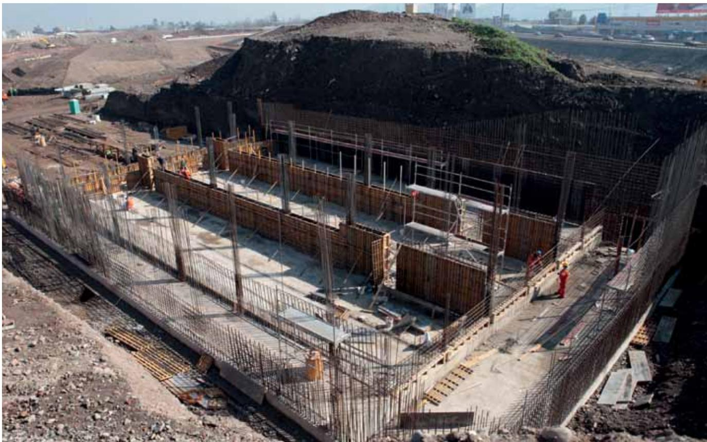
▲ El sedimentador es un edificio de hormigón armado que aloja en su interior salas de operación, compuertas y salas eléctricas. Sus grandes dimensiones no son apreciadas pues las obras quedaron, en gran parte, insertas en las lomas del parque. Su función es regular el caudal de entrada el brazo del río y permitir la sedimentación del material fino que acarrea las aguas del Mapocho.
