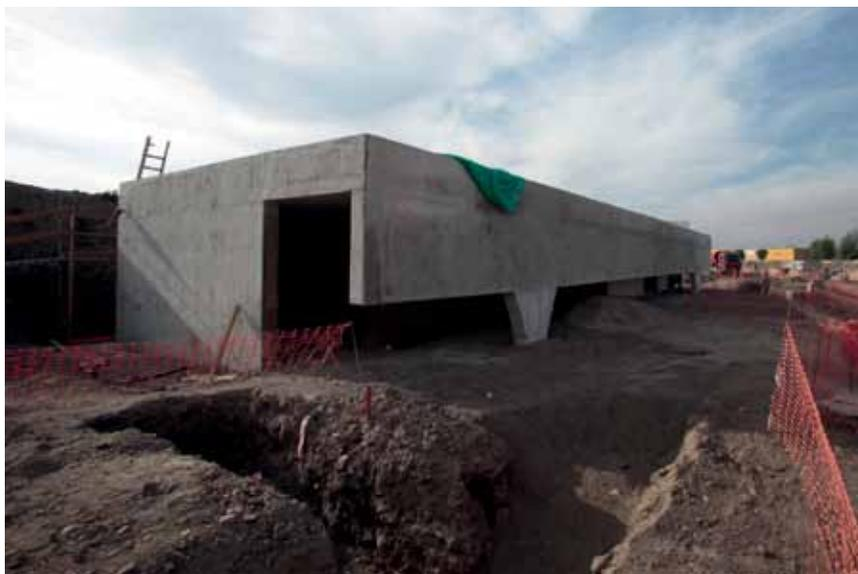
La obra de salida corresponde a una edificación en hormigón armado que queda totalmente bajo la superficie. En ella se ubican las compuertas que permiten el vaciado de la laguna, así como también la regulación de su nivel de llenado.
