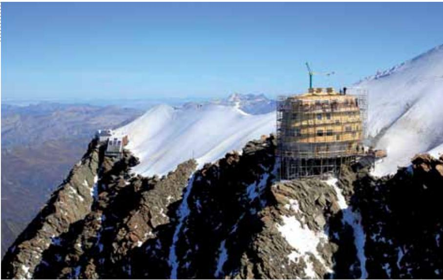
Se consideraron tres restricciones: estructura, tecnología y condiciones meteorológicas, las que llevaron a la adopción de un plano elíptico. El estudio contempló partes cóncavas para crear una forma aerodinámica que redujese la resistencia al viento.
