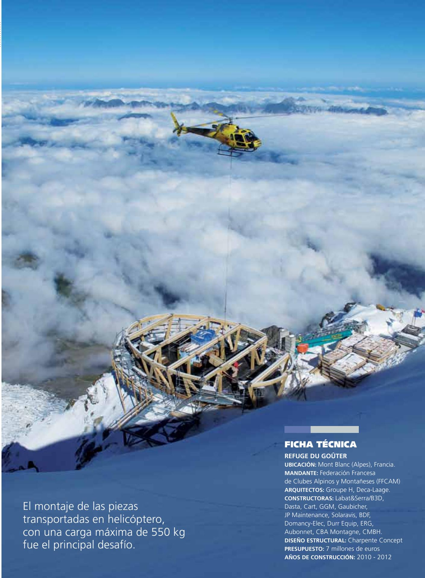
El montaje de las piezas transportadas en helicóptero, con una carga máxima de 550 kg fue el principal desafío.
